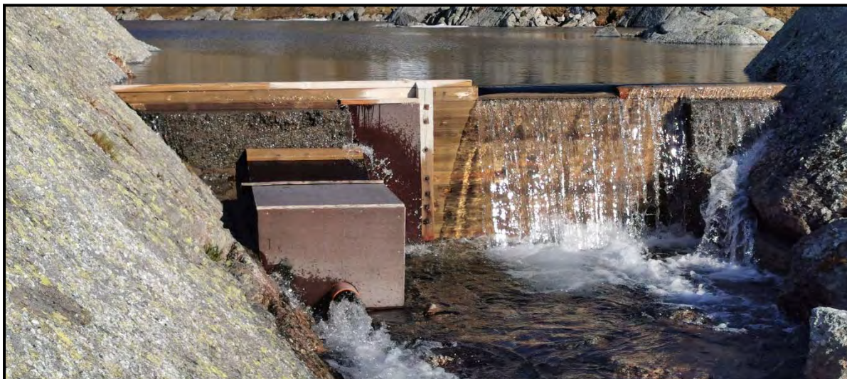
Figur 2-1 Dam Liåvatnet | Foto: Vevelstad kommune
